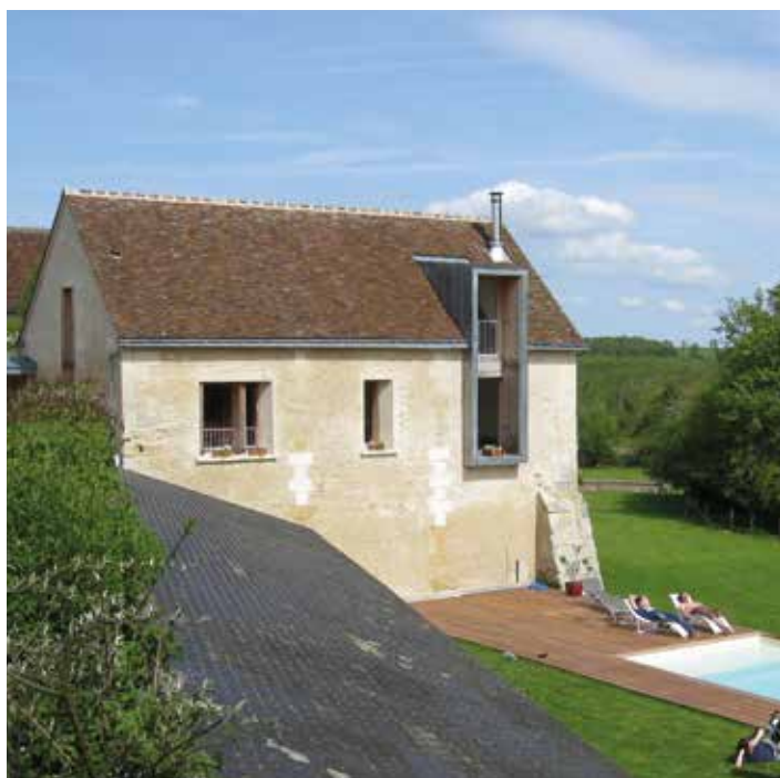
Réhabilitation d'une grange en maison bioclimatique, Reugny, 2008, Guillaume Belus & Adrien Henocq architectes © architectes
