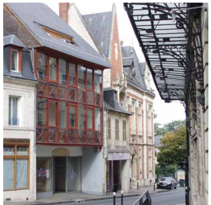
Refonte de trois immeubles médiévaux en secteur sauvegardé, Bourges, 2012, architecte Atelier Christian Gimonet © architecte
