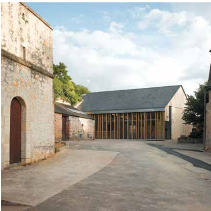
Salle de dégustation, Vouvray, 2010, Philippe Tardits Architecte © Brice Derez
