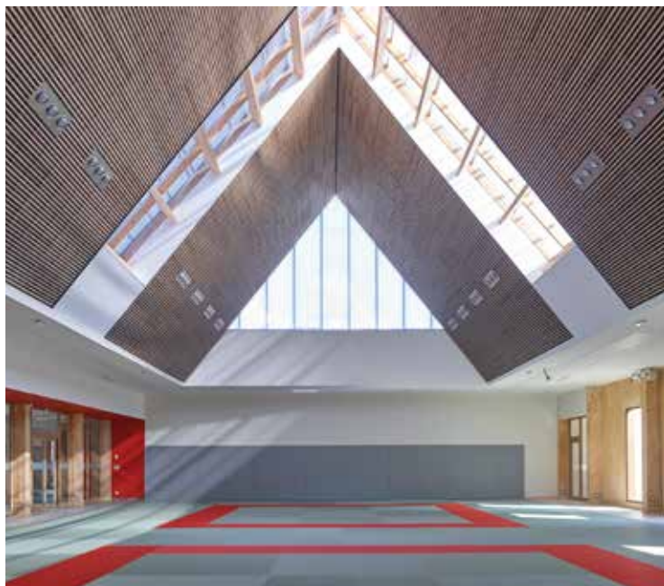
Construction d'une salle de sports de combat et d'arts martiaux, Châteauneuf-sur-Loire, 2015, architectes Atelier Poinville (Martin et Malou Lavaux) © Stéphane Chalmeau
