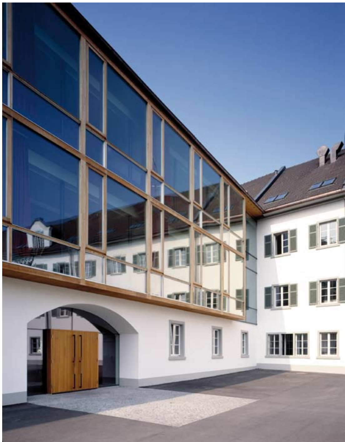
Réhabilitation à Mehrerau, Bregenz, H. Kaufmann arch. © Bruno Klomfar
