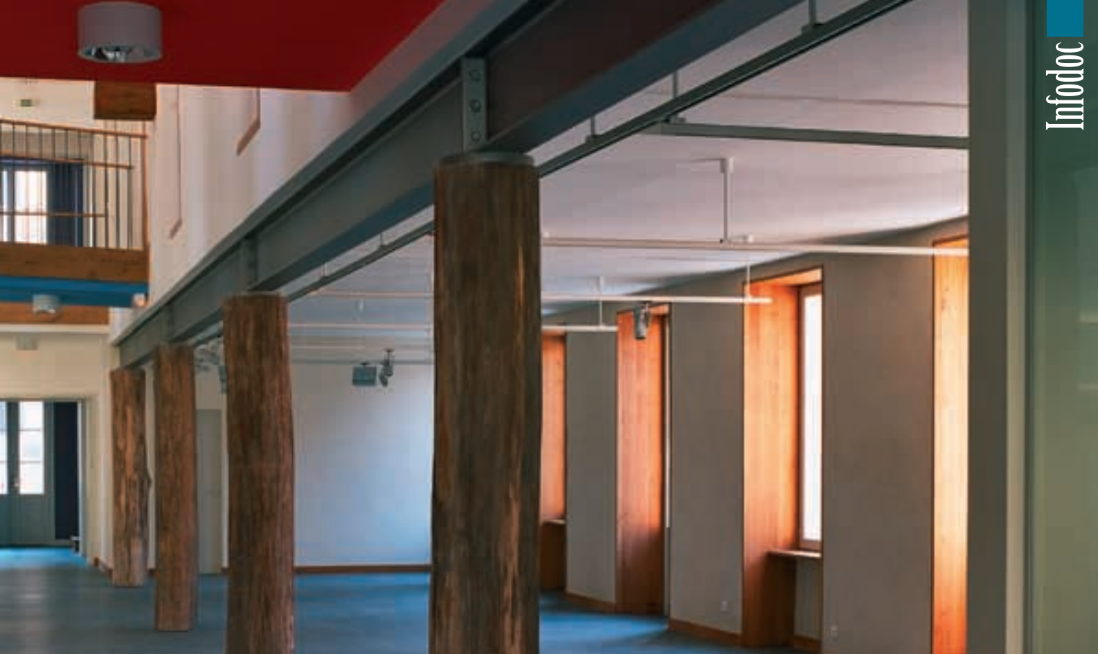
Réhabilitation de la maison diocésaine O. Prévost, Châlons-en-Champagne, ambiance intérieure, Christian Hackel-Méandre arch., 2004 © Luc Boegly
