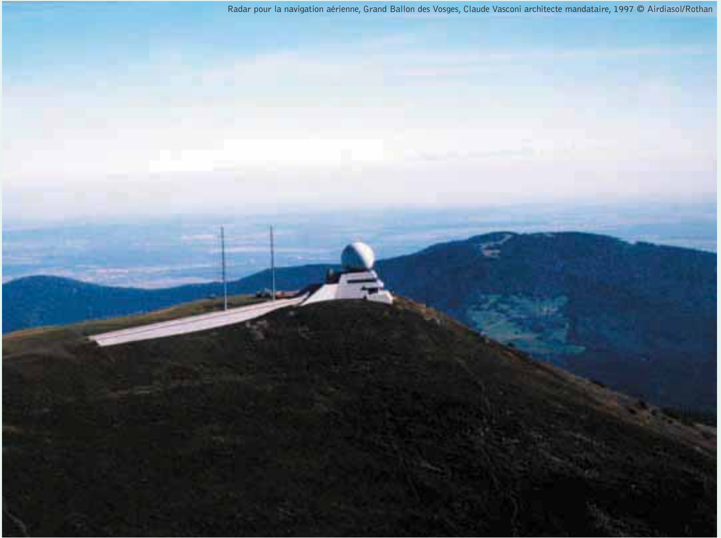
Radar pour la navigation aérienne, Grand Ballon des Vosges, Claude Vasconi architecte mandataire, 1997 © Airdiasol/Rothan
