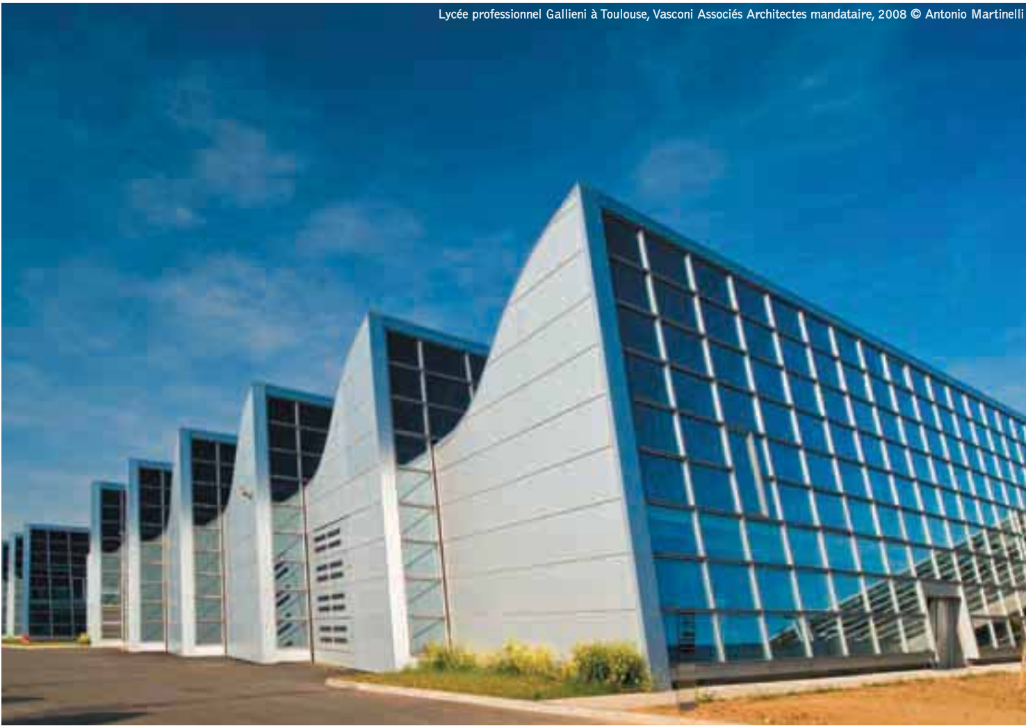
Lycée professionnel Gallieni à Toulouse, Vasconi Associés Architectes mandataire, 2008 © Antonio Martinelli
