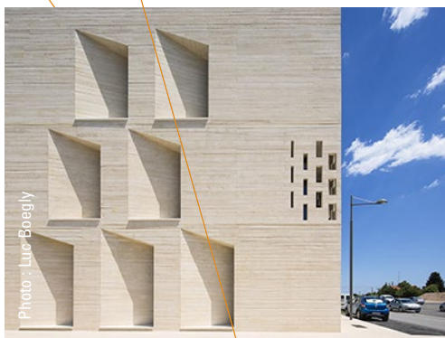
Réhabilitation des anciens hospices de Nîmes Projet Hoche-Sernam mené par la ville de Nîmes
