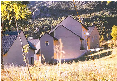
HLM Le Rozier (48) et détail de garde-corps
