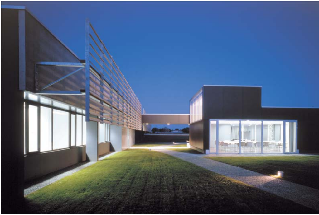
Espace d'entreprises Keraiaà Ploufragan, Nathalie Coquard, Jean-François Collet arch. © Luc Boegly, Archipress - Cahiers n° 13
