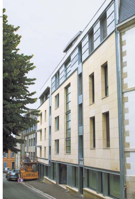
Construction de 38 logements à Quimper, Thierry Mostini, Julien Mostini architectes, lauréats catégorie habitat collectif © Yves René Caoudal
