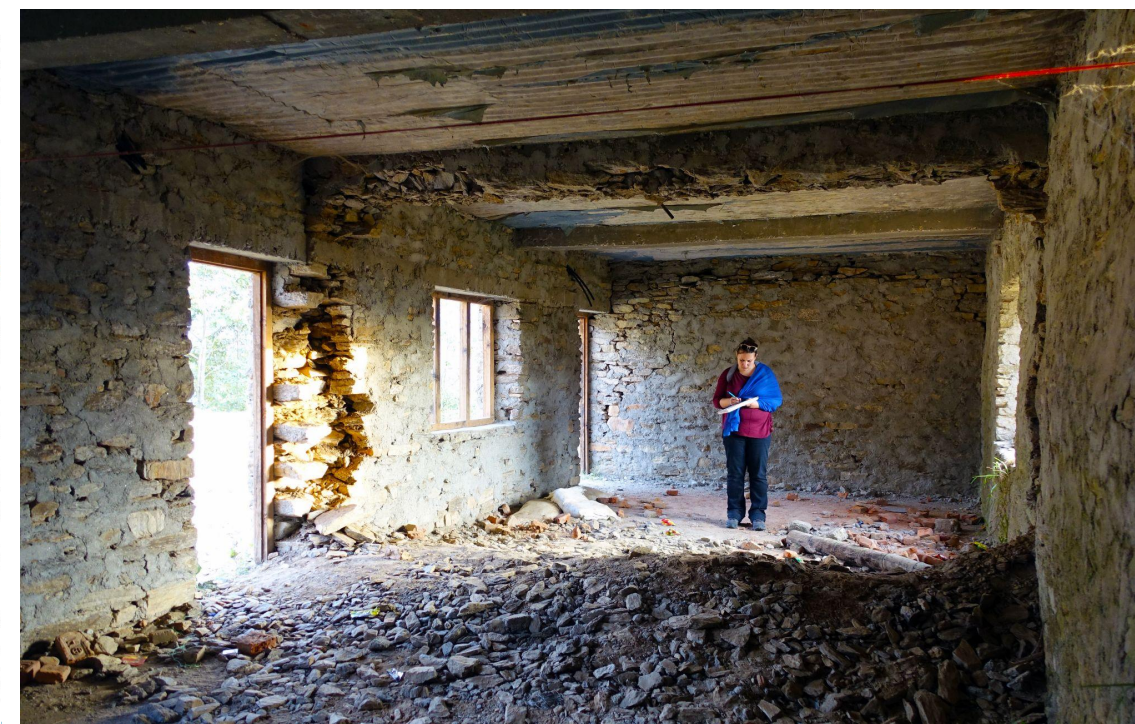
effondrement de l'étage de stockage
