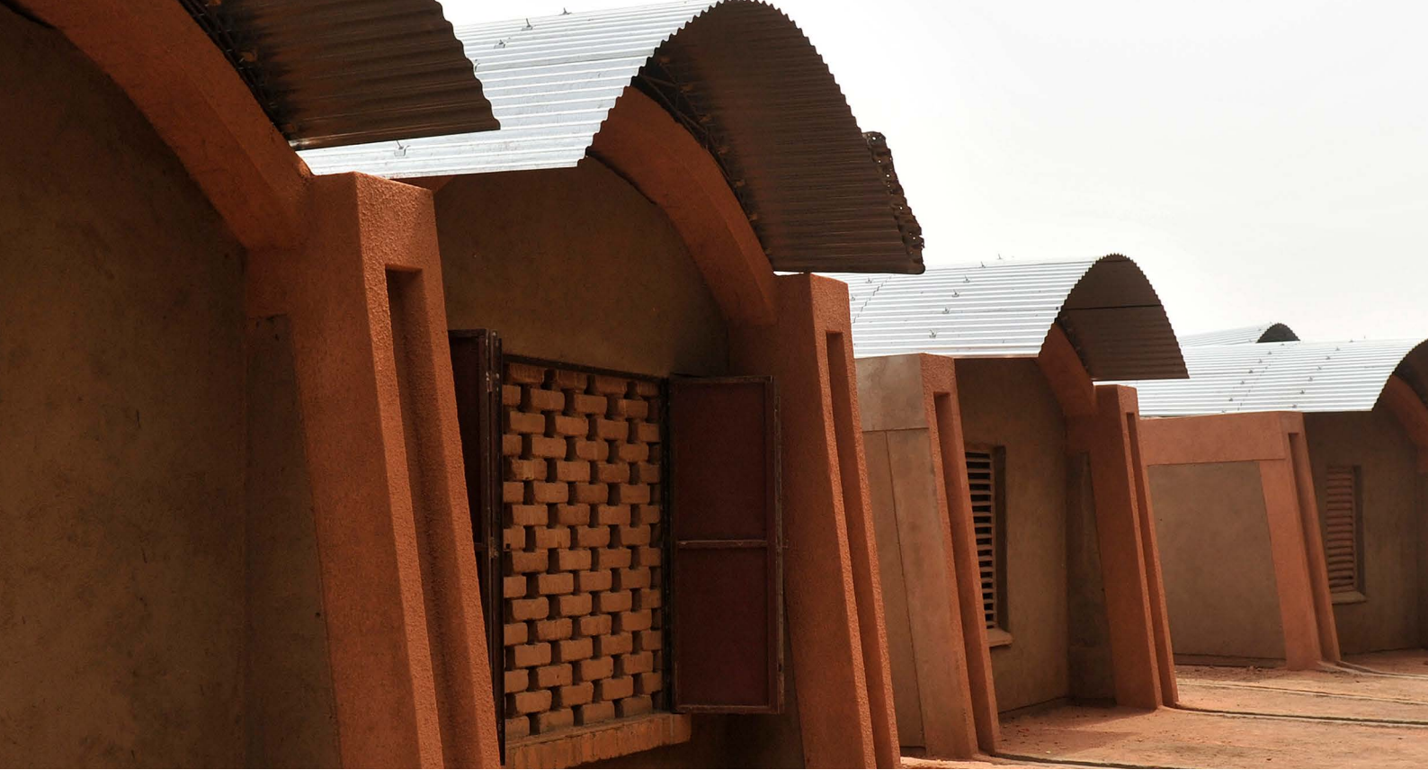
Maison des professeurs à Gando au Burkina Faso ©Diebedo Francis Kere
