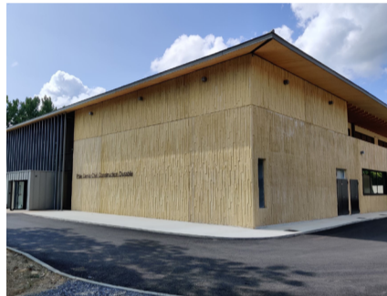
Extension de l'IUT Génie Civil de Tarbes Mil Lieux Architecture (Nancy) GP Architectes (Tarbes)
