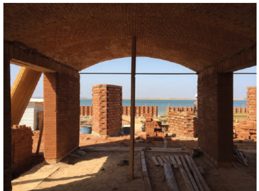
Agence AAP, chantier d'un projet en Terre-Bois-Pierre-Typha Sénégal
