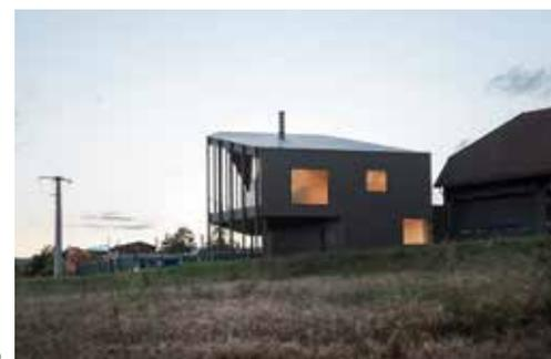
dans ce paysage rural. Le métal est le matériau idéal pour un chantier contenu dans le temps. La modélisation Bim puis la préfabrication ont été de précieux outils pour une précision parfaite de la mise en œuvre des édifices.
