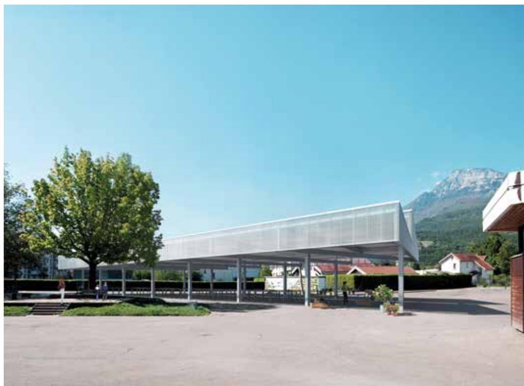
**La halle de Fontaine est aérienne. L'effet de légèreté est obtenu par l'utilisation d'une structure porteuse en acier galvanisé.**
