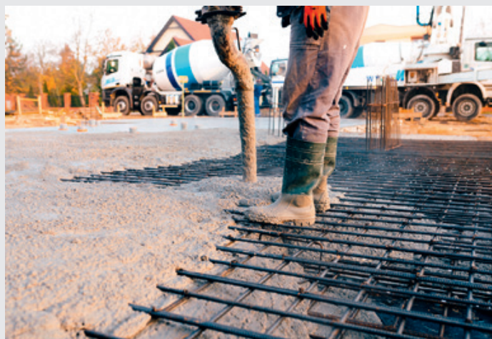
Coulage d'un bâtiment en béton de ciment avec ferrailages, branches, camion-toupie
