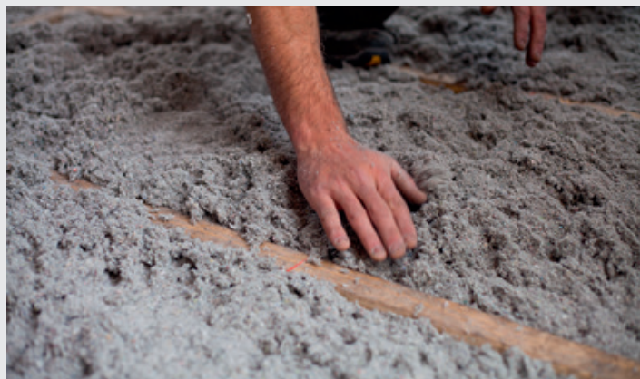
Isolation du sol avec de la ouate de cellulose, fabriquée à partir de papier recyclé
