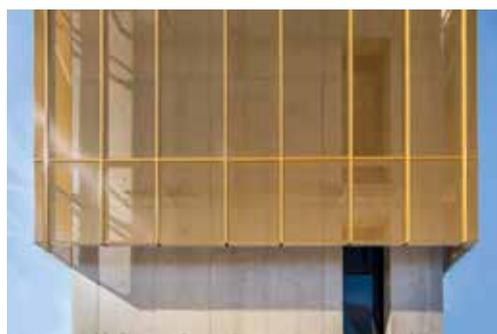
le bâtiment à une hauteur d'un peu plus de onze mètres. En débord de quarante-cinq centimètres par rapport aux murs hexagonaux en béton, la double peau est constituée d'un métal déployé de teinte dorée reprise sur une structure métallique.
