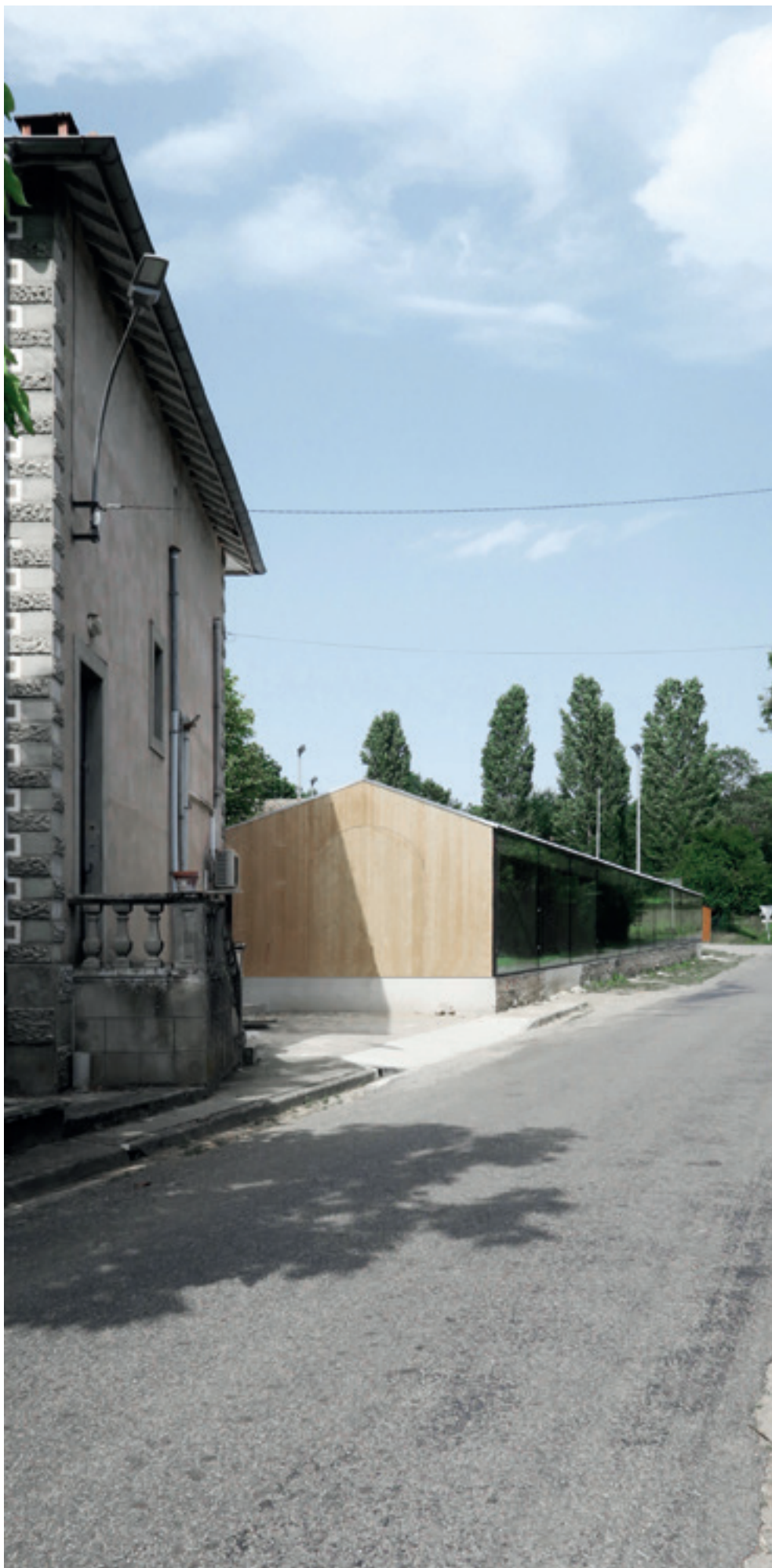
Prix Architecture Occitanie 2017 - Construction d'un réfectoire scolaire, Montbrun-Bocage 31310, BAST © BAST
