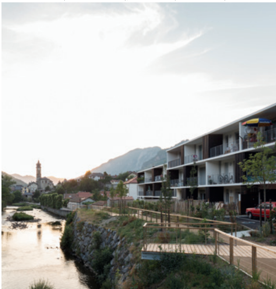
Prix Architecture Occitanie 2017 - Renouvellement urbain du quartier Labessard, Luzenac 09250, HARTER architecture (architecte mandataire), Emmanuel Plat (architecte associé) © Kevin Dolmaire
