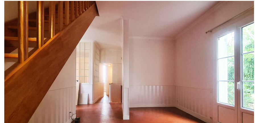
VUE AVANT TRAVAUX - DEPUIS LA SALLE À MANGER
