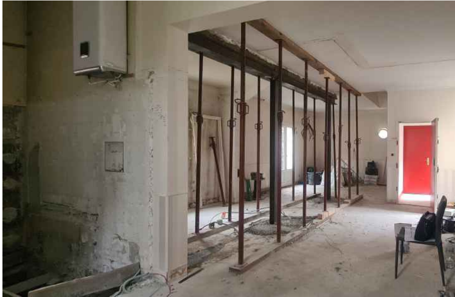
DURANT LES TRAVAUX - OUVERTURE DE BAIE
