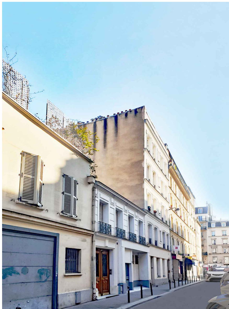
AVANT - L'EXISTANT AU 8 RUE DES APENNINSE
