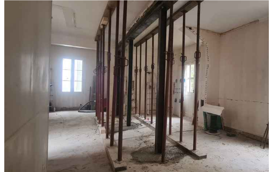
DURANT LES TRAVAUX - OUVERTURE DE BAIE
