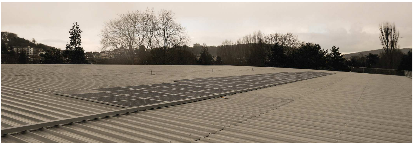
Toiture du bâtiment avant la pose des panneaux photovoltaïques
