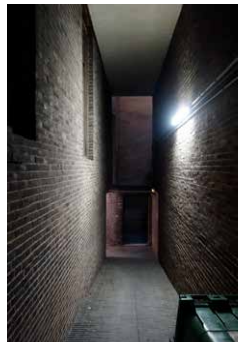
Rampe d'accès au sous-sol à restaurer
