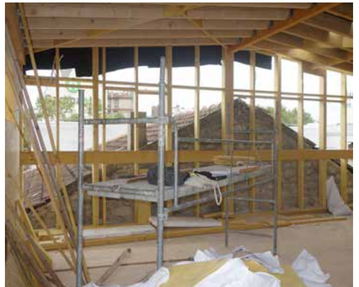
Mise en œuvre de la charpente et des planchers bois en pin et panneaux d'OSB
