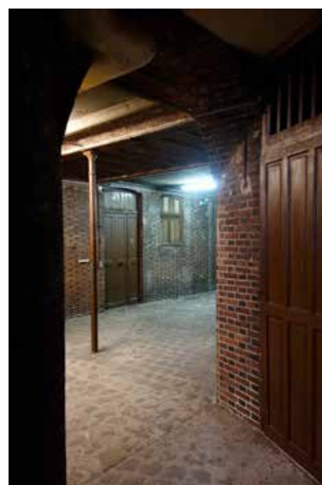
Ancienne cour des écuries à restaurer
