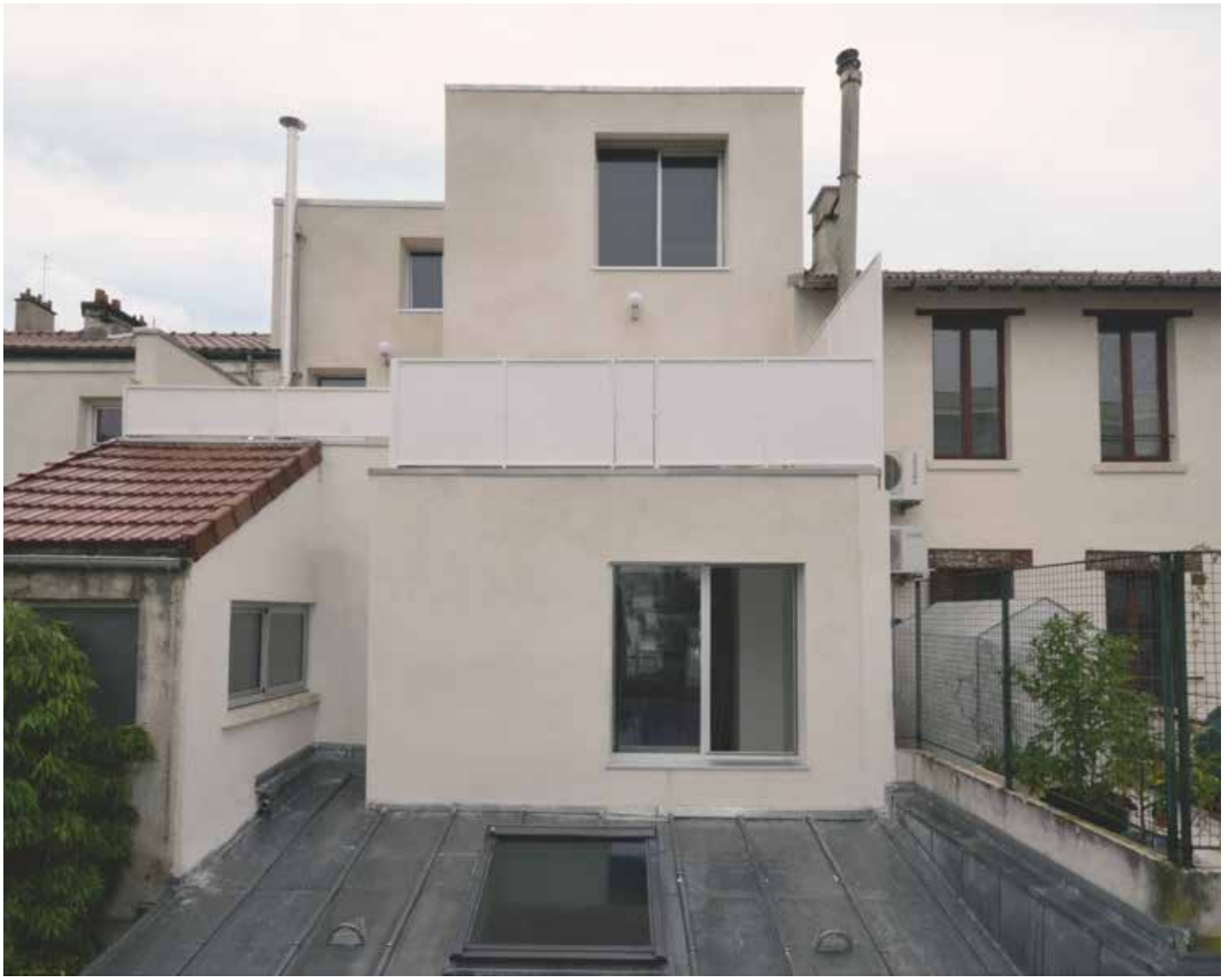
Façade Sud avec une grande terrasse après surélévation
