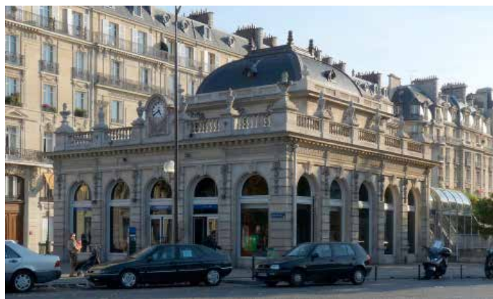
2015 Façades Nord et Ouest
