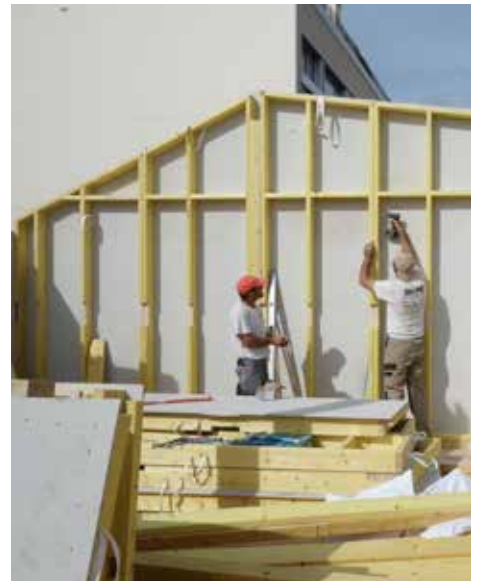
Montage et assemblage de l'ossature bois avec panneaux de fermacell (panneaux de fibre-gypse) pour le contreventement et pour le coffrage perdu du béton de chanvre
