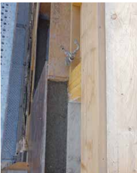
Mise en œuvre du béton de chanvre (entre les panneaux de fermacell (panneaux de fibre-gypse) en coffrage perdu et les panneaux de contreplaqué) et de l'enduit à la chaux
