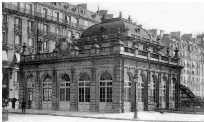
1900 Façades Nord et Ouest
