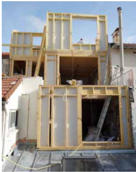
Montage et assemblage de l'ossature bois avec panneaux de fermacell (panneaux de fibre-gypse) pour le contreventement et pour le coffrage perdu du béton de chanvre
