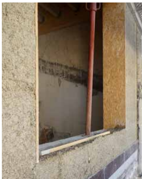
Mise en œuvre du béton de chanvre (entre les panneaux de fermacell (panneaux de fibre-gypse) en coffrage perdu et les panneaux de contreplaqué) et de l'enduit à la chaux
