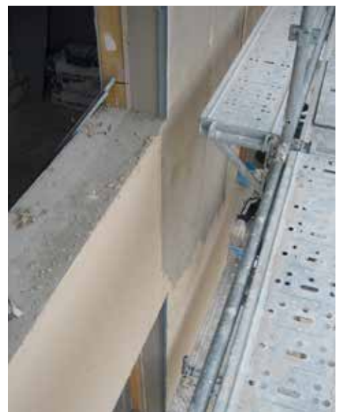
Mise en œuvre du béton de chanvre (entre les panneaux de fermacell (panneaux de fibre-gypse) en coffrage perdu et les panneaux de contreplaqué) et de l'enduit à la chaux
