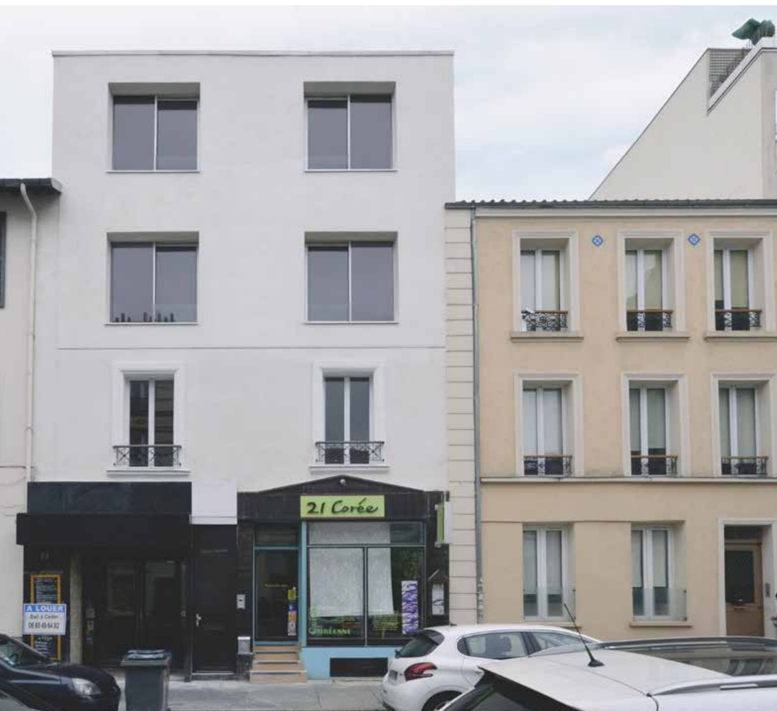
Façade Nord après surélévation
