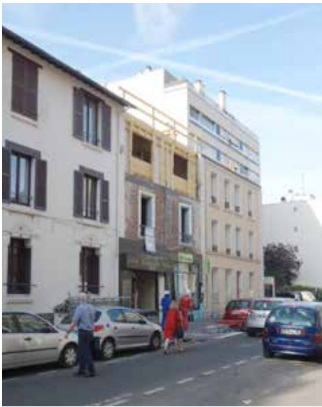
Montage et assemblage de l'ossature bois avec panneaux de fermacell (panneaux de fibre-gypse) pour le contreventement et pour le coffrage perdu du béton de chanvre
