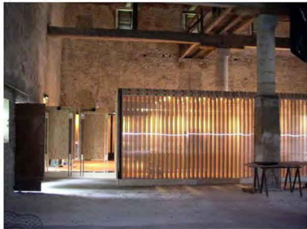
Structure légère bois de l'espace d'accueil
