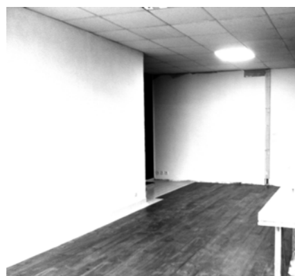
Pose du parquet
