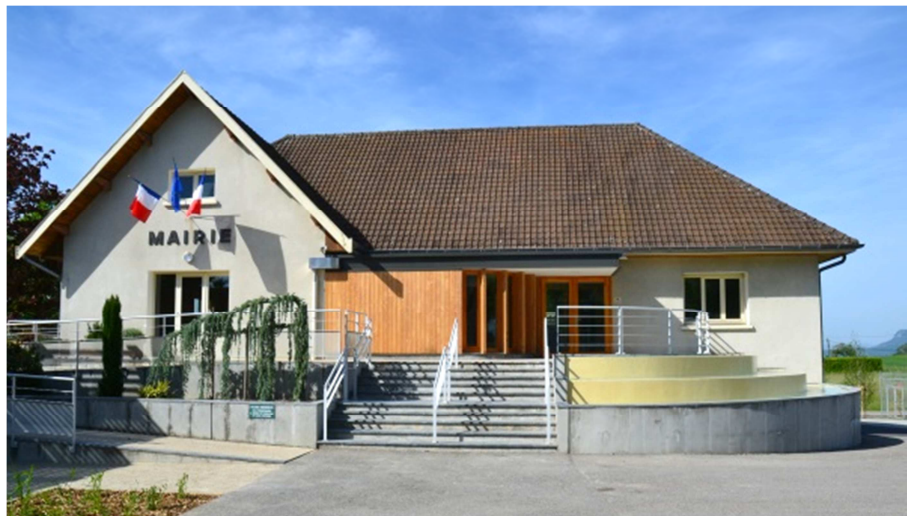
Extension partie Poste à l'avant de la mairie, sur la rampe le parvis existants
