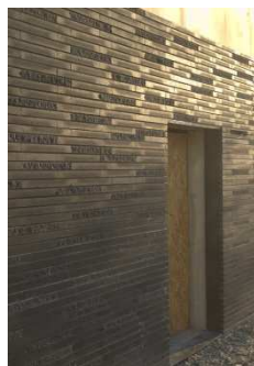
Mise en œuvre de la brique : calepinage
