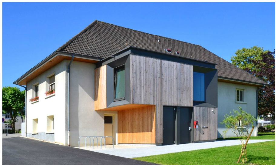
Extension des bureaux à l'arrière de la mairie
