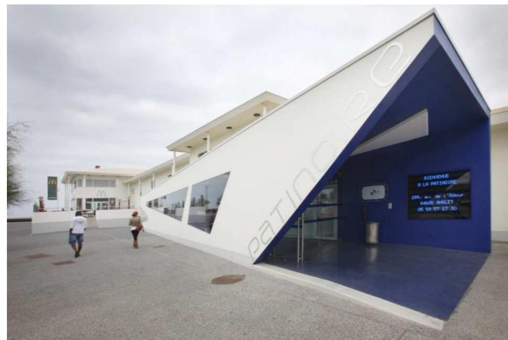
Entrée de la patinoire après travaux
