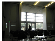
Salle de cérémonie - avant travaux
