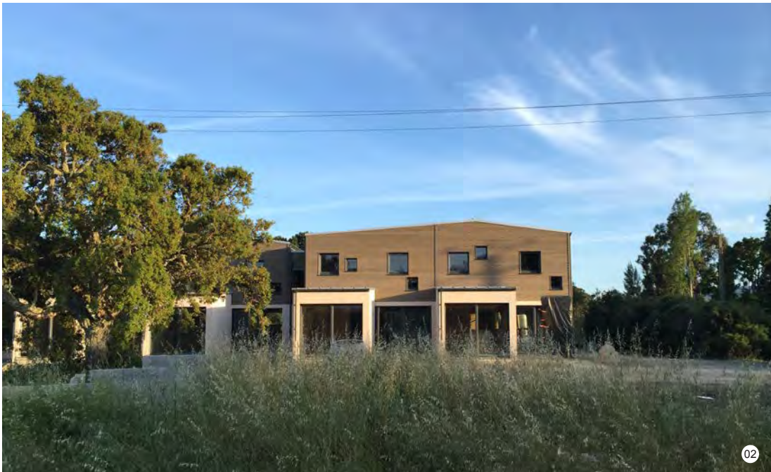
1 - 2 - 3 - 4 - 5 - Résidences individuelles groupées, travaux en cours (© WIMM)
