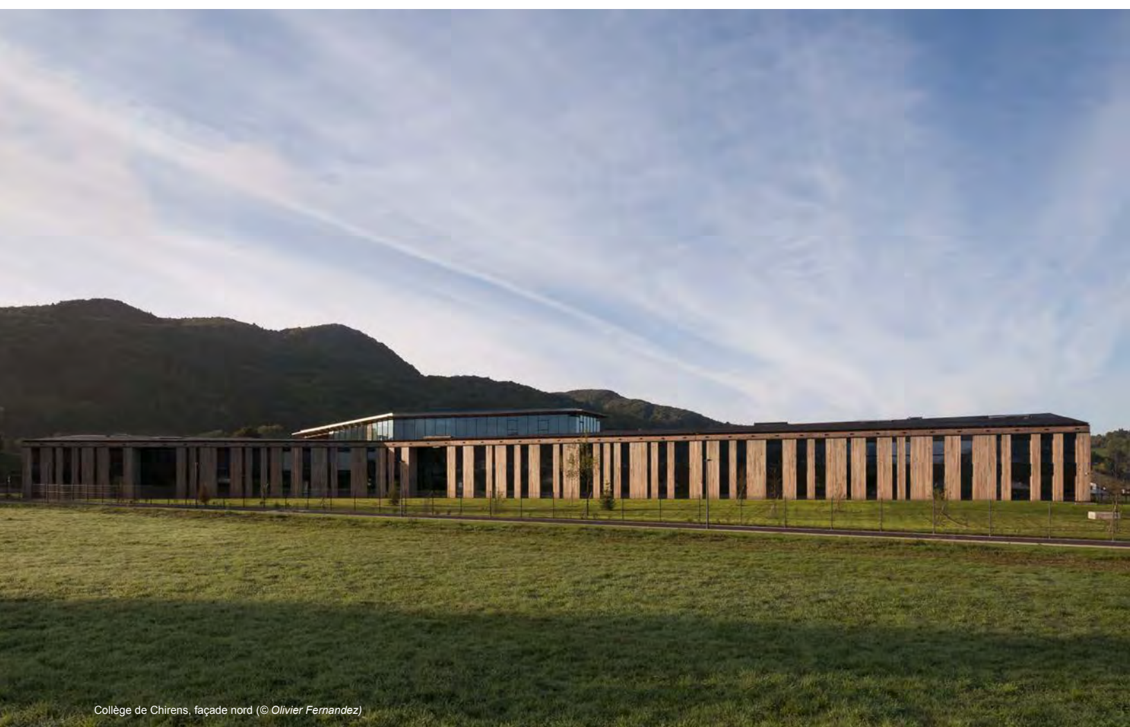
Collège de Chirens, vue des toitures (© Olivier Fernandez)
