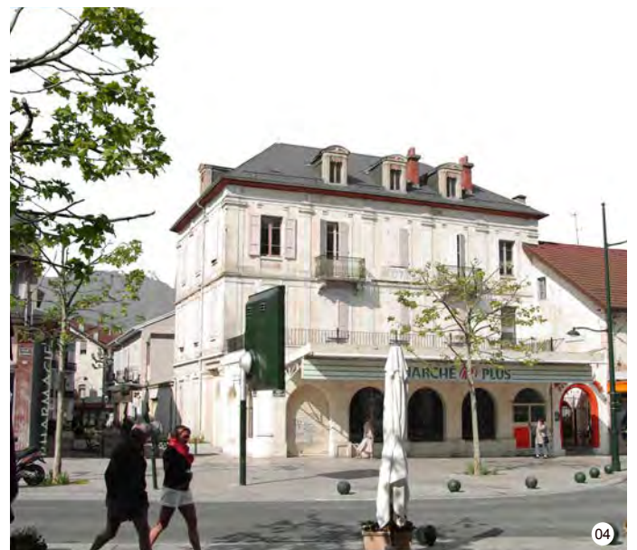
04 - Bâtiment existant en 2012 - Façade principale (© WIMM)
