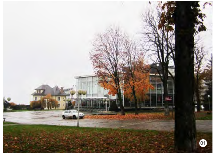
01 - Bâtiment existant en 2012 - Façade principale (© WIMM) 02 - Bâtiment existant en 2012 (© WIMM)
