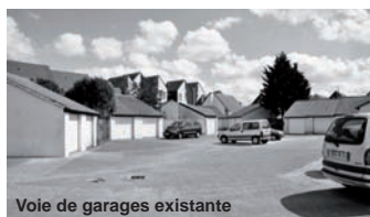
Voie de garages existante
