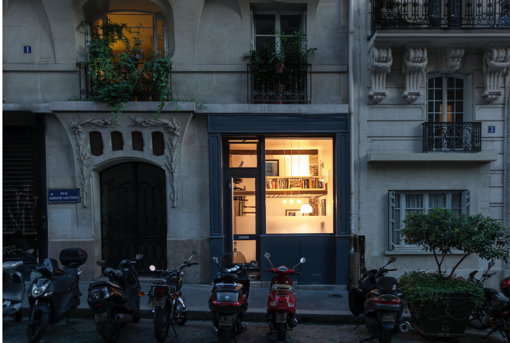
Transformation d'un local de cordonnier en bureaux Paris 18 e
