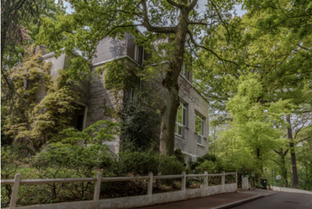
Surélévation en ossature bois d'une maison classée au Plessis Robinson (92)
