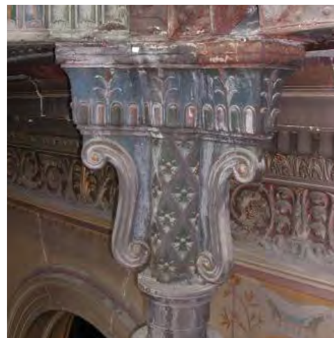
Photo avant travaux
