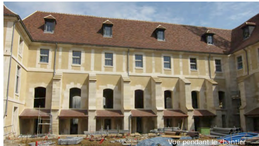
Vue pendant le chantier
