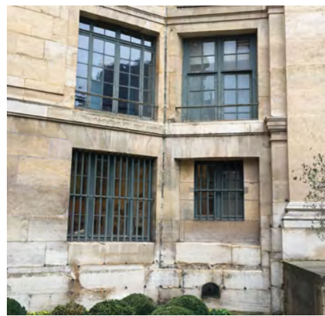
Élévation de la façade existante
