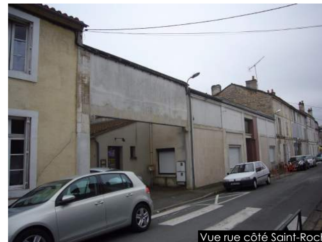
Vue rue côté Saint-Roch
