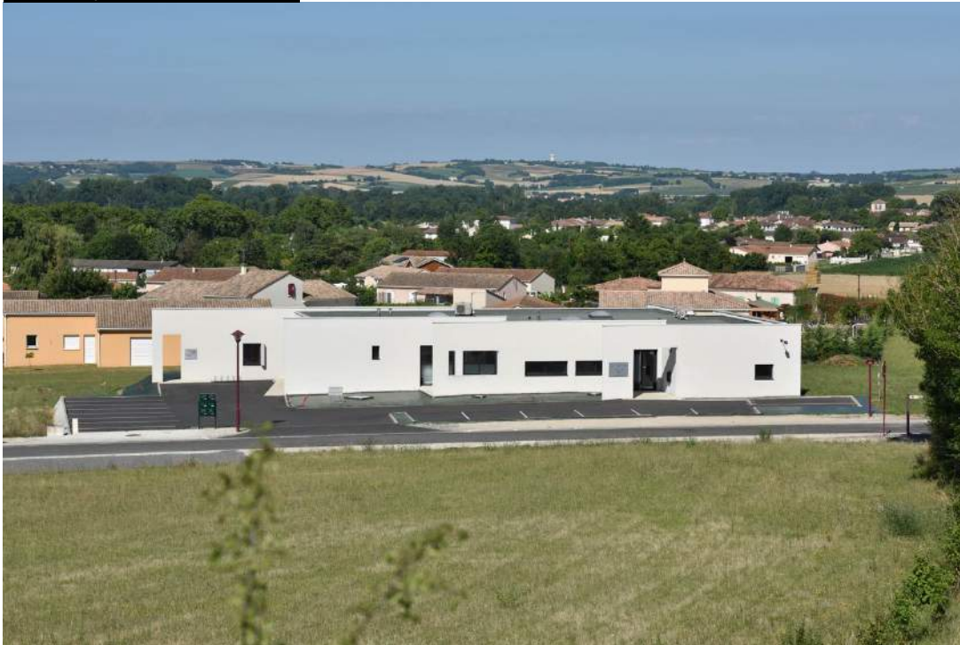
Vue depuis la voie ferrée
