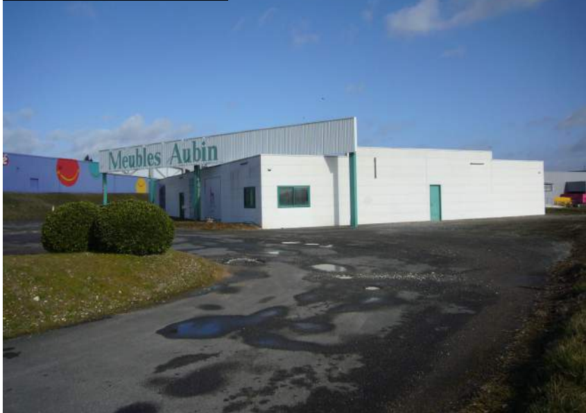
Vue depuis l'accès rue
