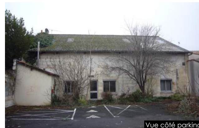
Vue côté parking
