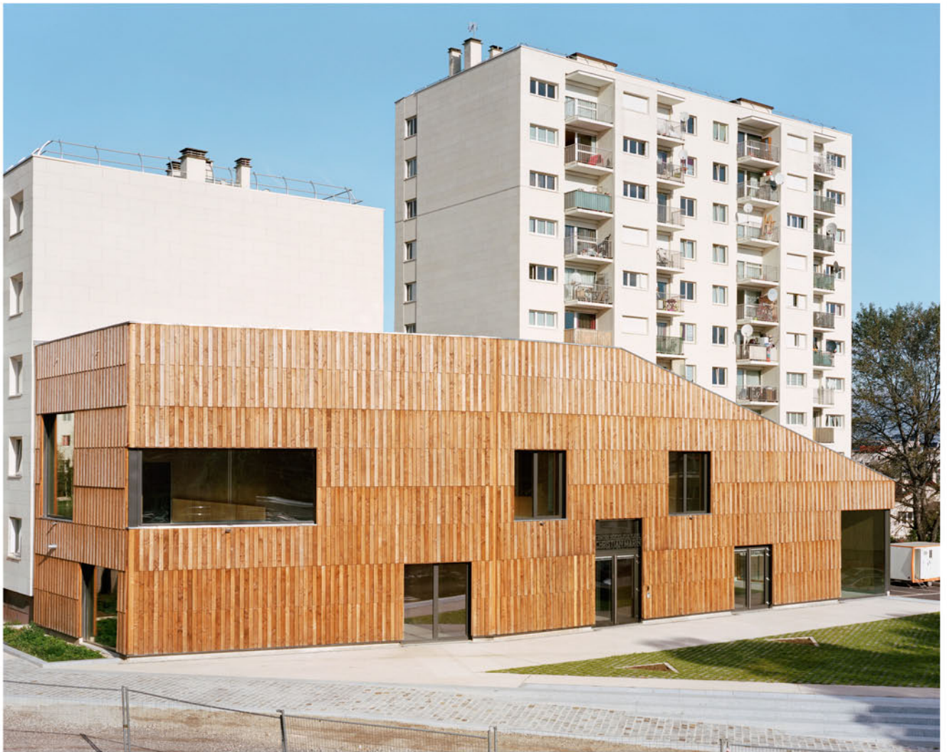
Façade est, sur la nouvelle Place d'Aquitaine (ci-dessus). Bardage bois autour de la séquence d'entrée (page ci-contre).
