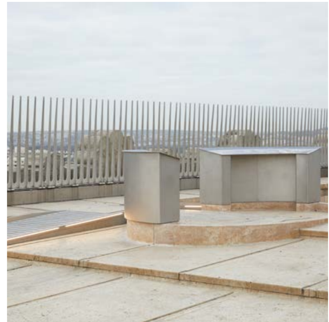
Rampes d'accessibilité et signalétiques contemporaines
