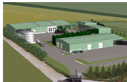
Réaménagement d'un site industriel Chevilly (45)
