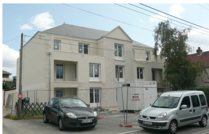
Construction de 10 logements Orléans (45)
