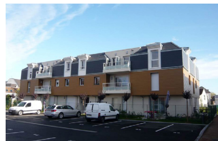
Construction de 36 logements et 20 logements individuels Saint-Denis-en-Val (45)
