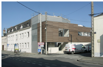
Construction d'un EHPAD et d'une résidence sénior Orléans (45)
