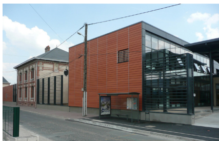
Reconstruction de la Couronnerie La Chapelle Saint Mesmin (45)
