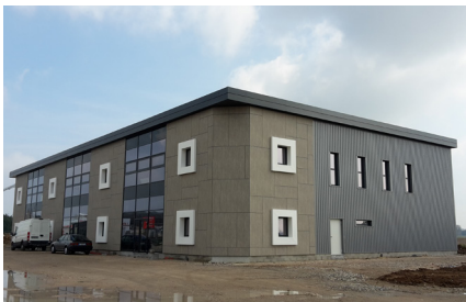
Bâtiments de bureaux Saint-Jean-le-Blanc (45)
