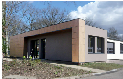
Extension et restructuration de la cuisine de réchauffage d'une IME Orléans (45)
