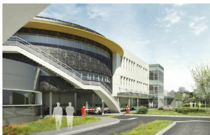
Centre de dépôt et de maintenance de bus Metz (57)
