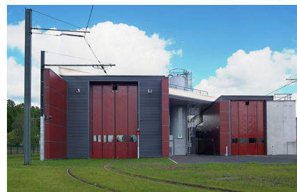
Atelier dépôt de tramway Le Mans (72)
