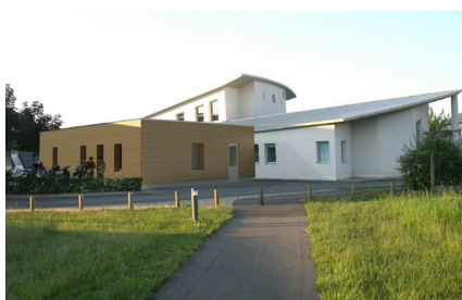
Extension du centre culturel Léo Lagrange. Saint-Pryvé-Saint-Mesmin (45)
