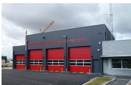
Construction de 6 SDIS Loiret (45) Pour le Conseil Départemental du Loiret Livré en 2015
