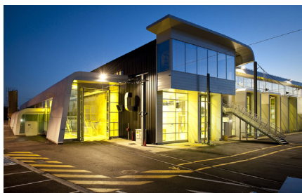
Centre de maintenance et de remisage tramway Tours (37)
