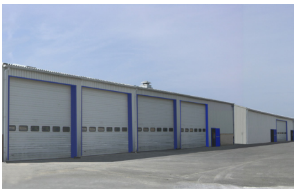
Restructuration d'un centre d'exploitation et de travaux Gien (45)
