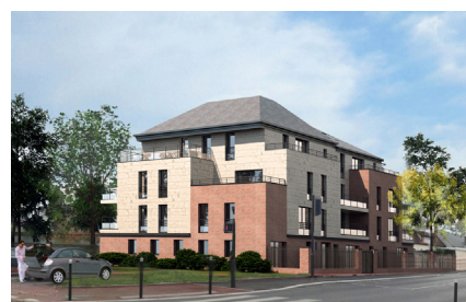
Résidence des Capucines (22 logements) Olivet (45)
