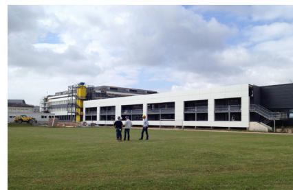
Réhabilitation et extension du lycée Edouard Branly Dreux (28)
