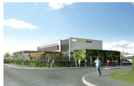
Dépôt de bus Blois (41)
