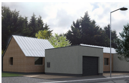
Construction de 20 maisons et une maison commune Olivet (45)
