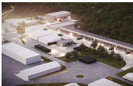
Aménagement des infrastructures de la zone technique des V.B.M.R Caserne militaire, Avrillé (49)
