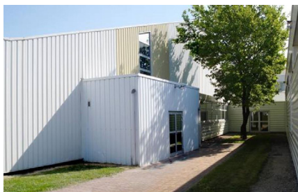
Redeploiement de locaux sportif et construction d'un cours de tennis Saint-Denis-en-Val (45)
