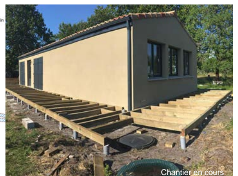
Chantier en cours
