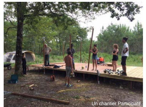
Un chantier Participatif
