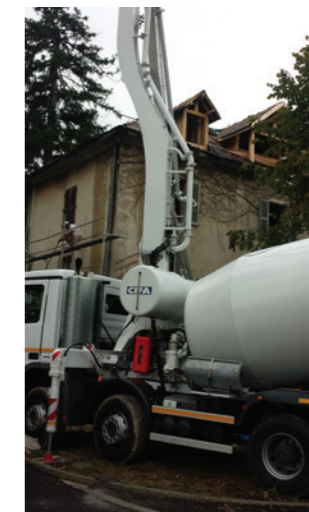
Photo des travaux
