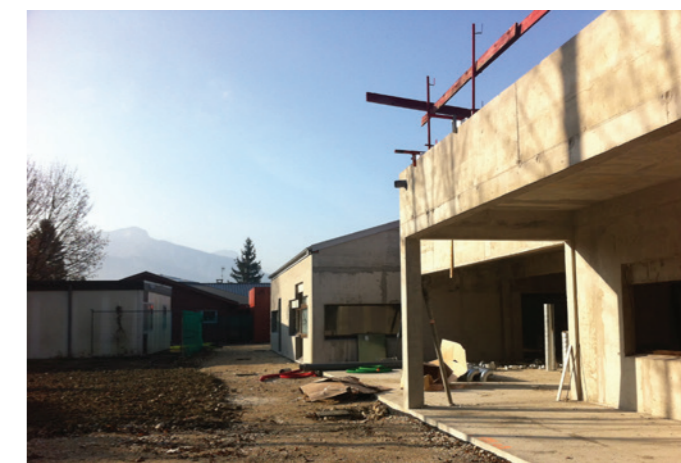
Photo du chantier
