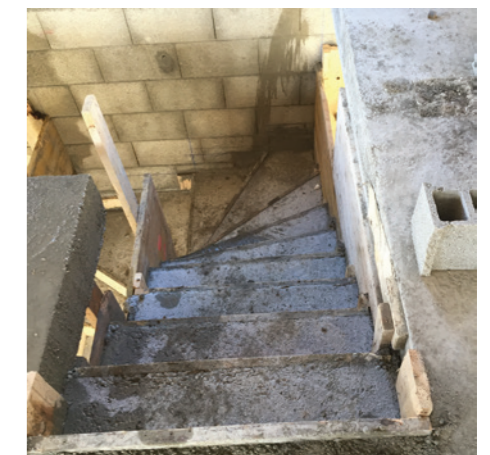
Photos du chantier
