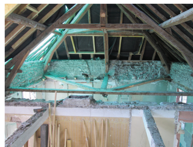
Photo des travaux
