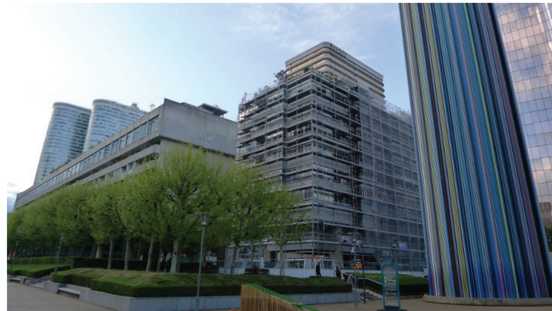
Pose d'isolation thermique extérieure et bardage en panneaux composites
