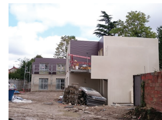
Finition des façades
