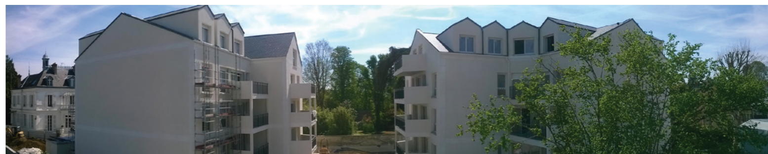
Vues panoramiques du chantier à différents stades d'avancement
