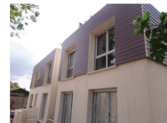
Finition des façades
