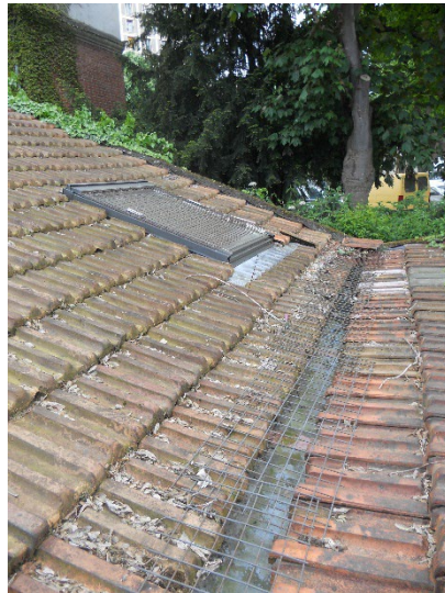
Schéma de principe de traitement de la jonction des différents pan de toiture
