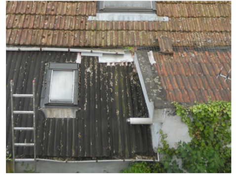
Photographie de la jonction des différents pan de toiture
