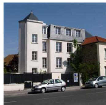
Une maison réalisée au sommet d'un petit immeuble de logements collectifs à Suresnes. L'appartement mansardé existant est déposé et remplacé par une habitation sur deux niveaux réalisée en ossature bois.
