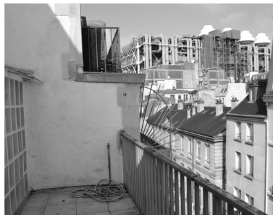
Etat existant de la terrasse en R+5
