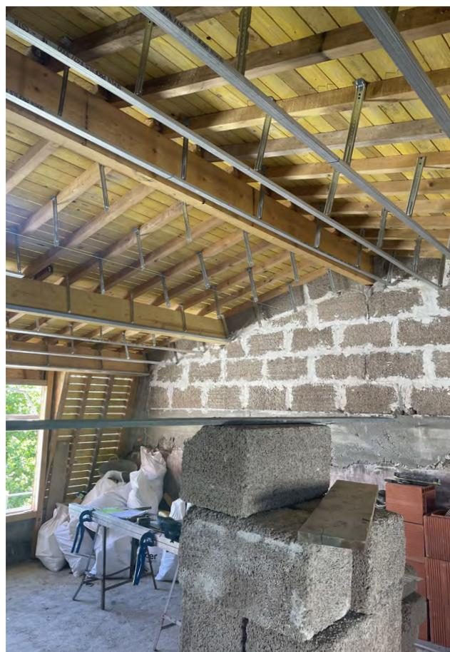
Chantier en cours - construction blocs de chanvre + bois
