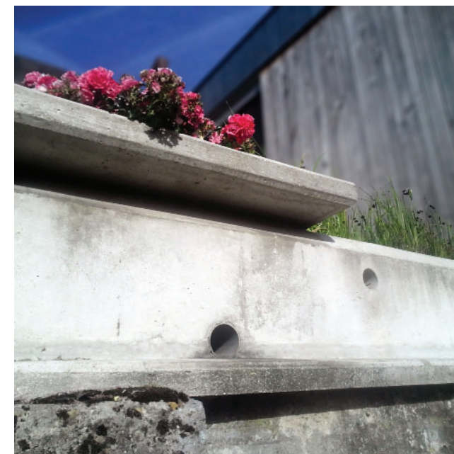
Soubassements et murets entrelacés en béton armé
