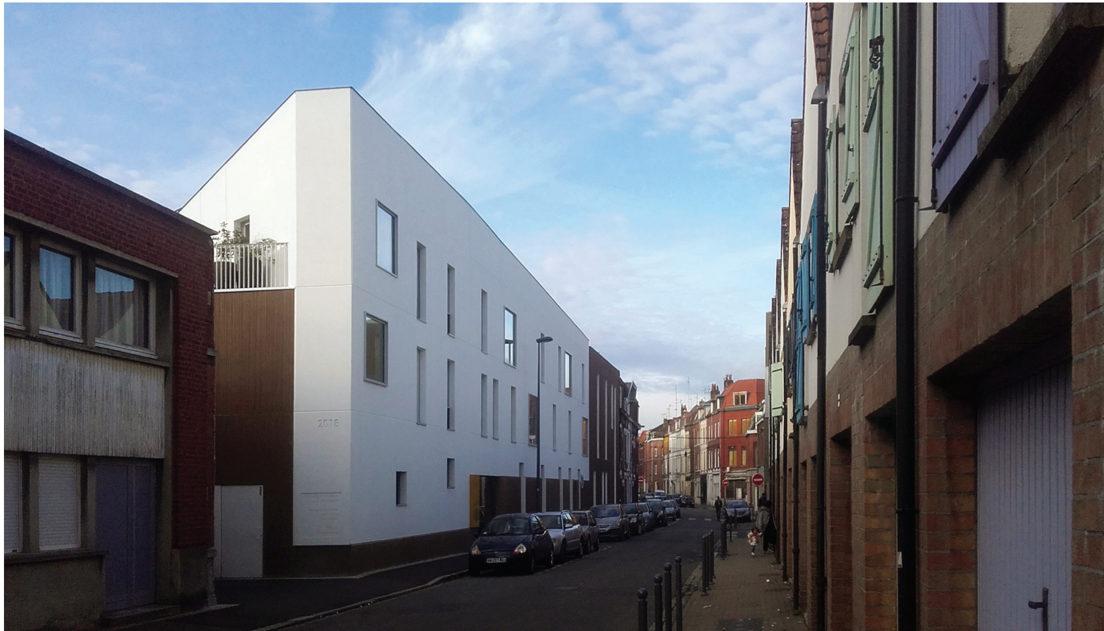
Façade sur rue, entrelacs complexe de bétons blancs et bruns
