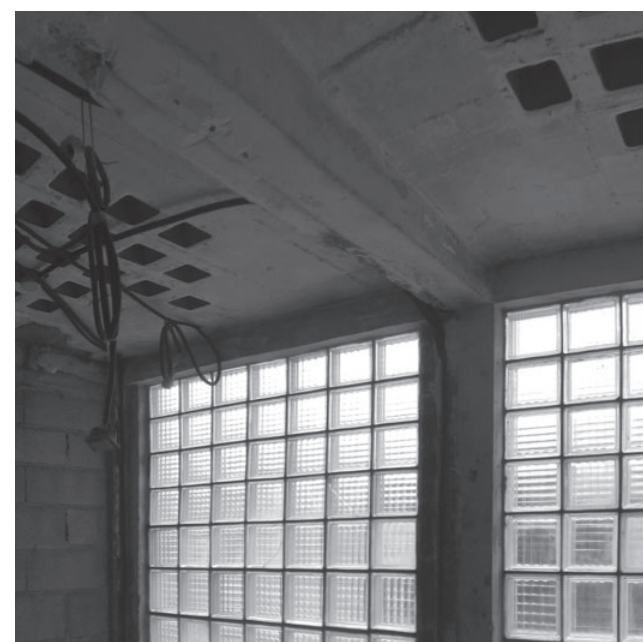
État existant | structure béton et inclusions de pavés de verre
