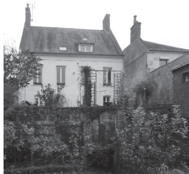
État existant | une cour dominée par un pignon aveugle
