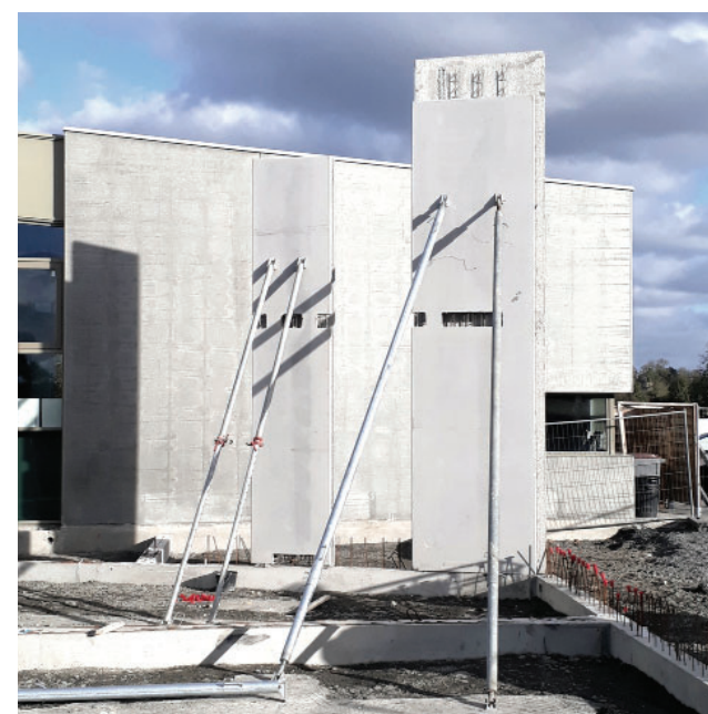
Préfabrication des bétons
