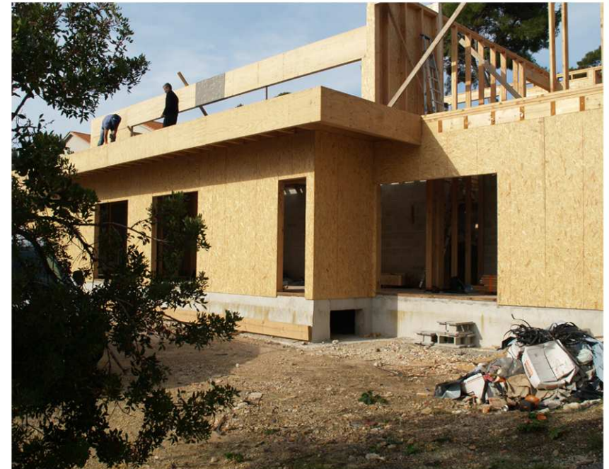
Maison à ossature bois (en cours de chantier)
