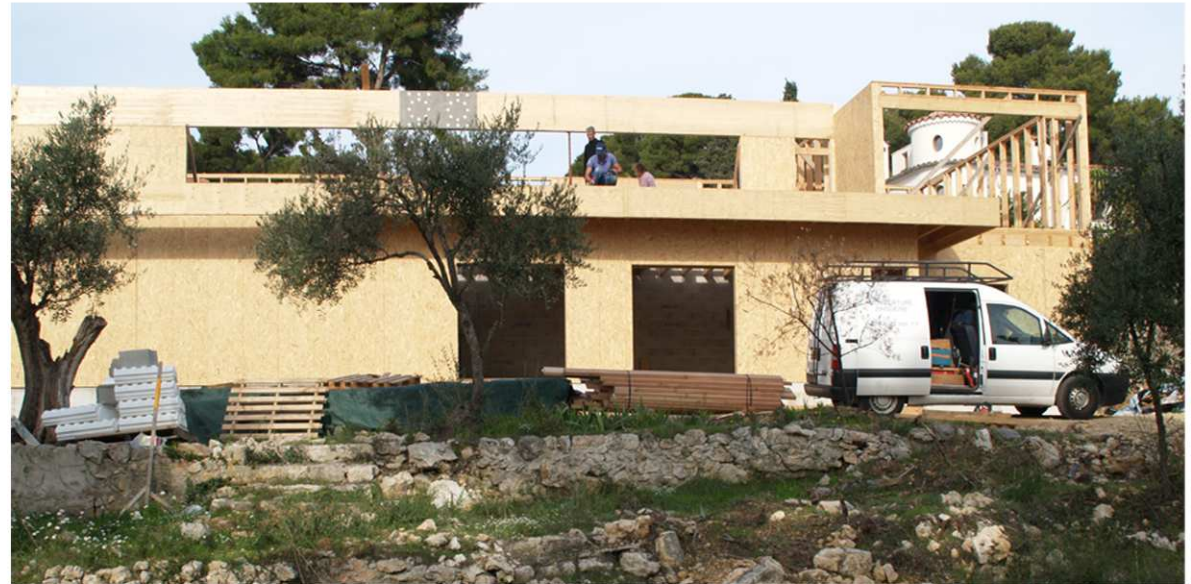
Maison à ossature bois (en cours de chantier)
