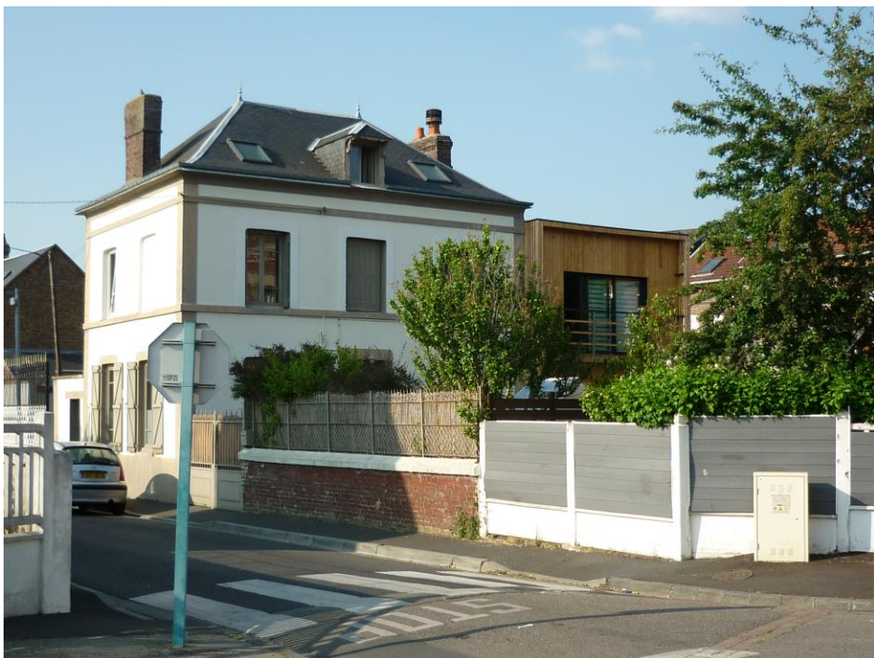
Projet F / Extension d'une habitation
