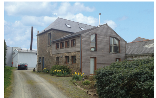
Réhausse ossature bois, Saint-Brandan (22)
