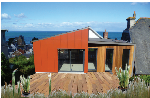
Extension-greffe d'une maison en bord de mer, Pléneuf-Val-André
