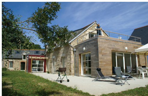
Réhabilitation d'un corps de ferme avec extensions, Plouézec (22)
