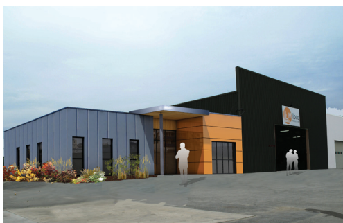
Bureau et hangar de production Milocco, Glomel (22)
