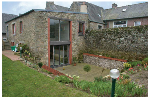
Transformation d'un garage en pièce de vie, Quintin (22)
