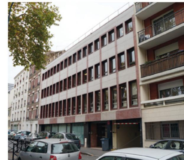
Réhabilitation lourde d'un immeuble tertiaire en hôtel 2\*\* de 98 chambres (Ibis Budget). Le bâtiment existant a été surélevé de 3 étages. La façade a été recomposée par l'extérieur en la dotant d'un manteau thermique permettant de requalifier architecturalement le bâtiment.
