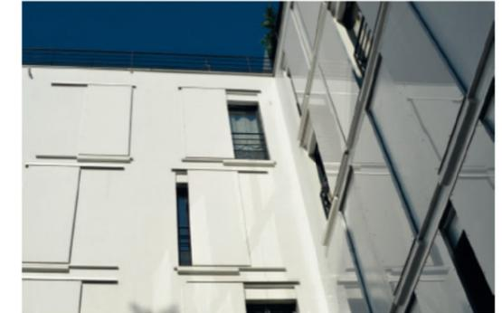
Construction d'un immeuble collectif de 106 logements comprenant 84 logements en Scellier social et une résidence étudiante de 22 appartements totalisant 35 lits. Deux niveaux de sous-sols sont prévus pour les parkings. Les façades sont en béton lasuré, parement de panneaux de bois composites et volets coulissants opaques en Altuglas.
