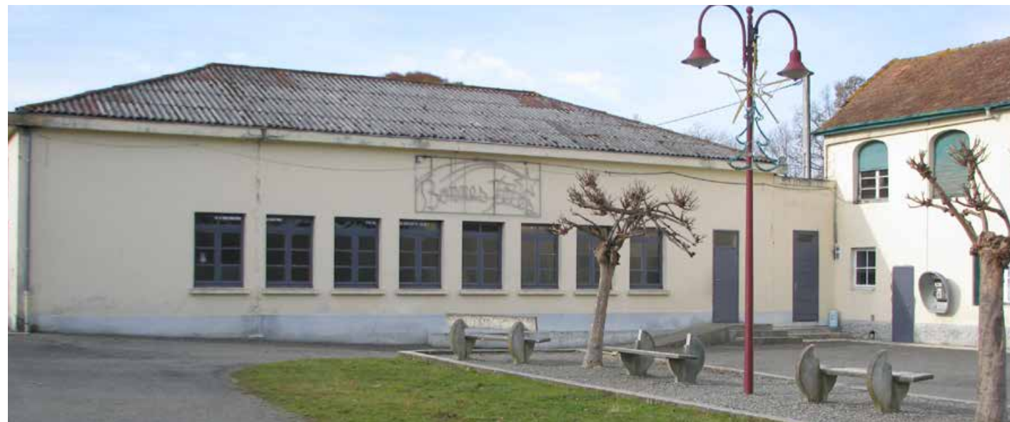
Le bâtiment existant
