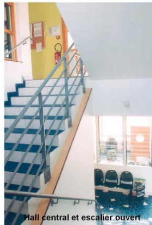
Hall central et escalier ouvert
