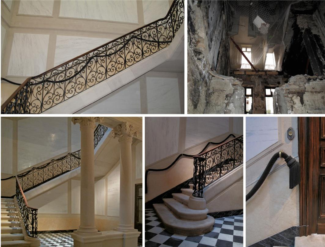
Rénovation d'un hôtel particulier du XIX<sup>ème</sup> siècle sinistré par un incendie, situé boulevard Gambetta à Nîmes. Restructurations en sous oeuvre de murs et planchers, reconstruction de murs de maçonnerie en moellons, réalisation de planchers connectés, préservation et restauration de staff, restauration et réfection des décors en stuc, marbrerie, fer forgé, menuiseries.
