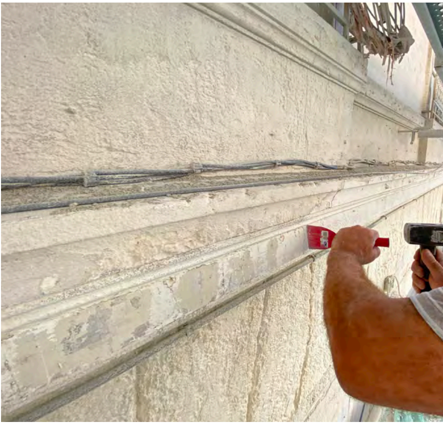
↗ Ravalement de la façade en pierre de taille et des éléments ornementaux qui la composent
