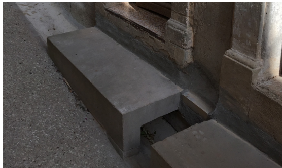
↳ Détails : marche «pont» sur la cunette qui conduit les eaux de ruissellement
