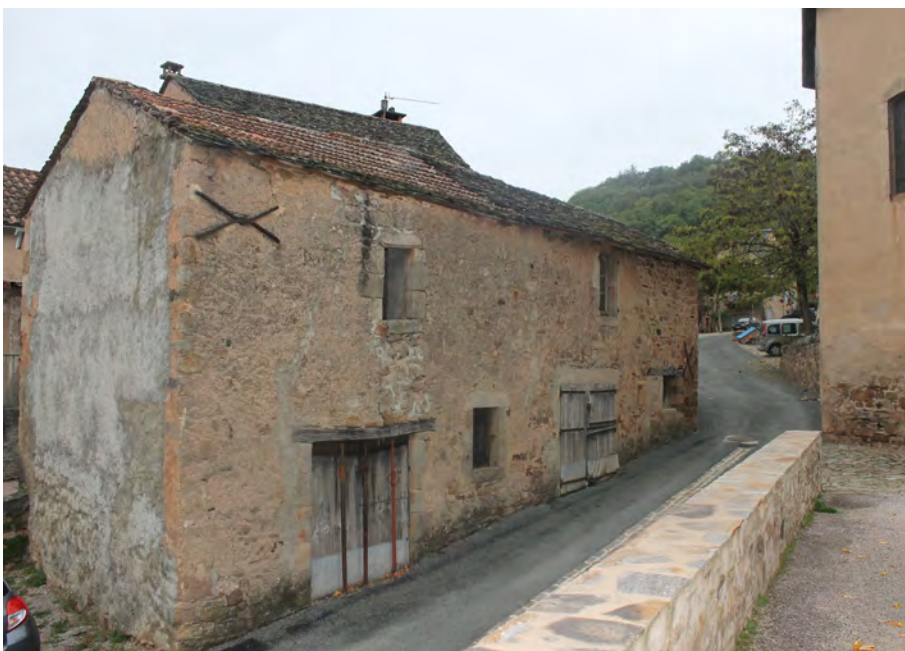
façade sur rue avant travaux
