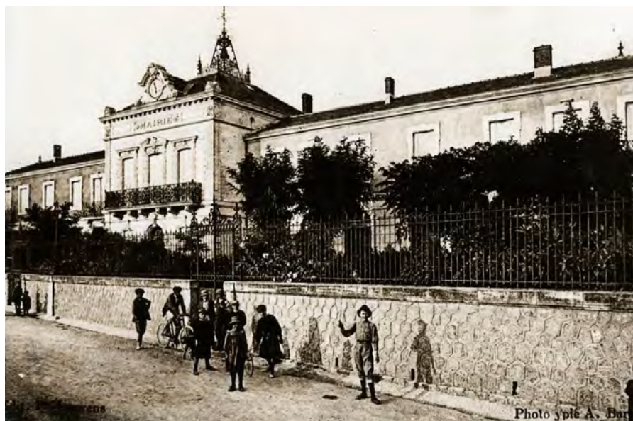
↳ La rue de la Mairie et l'angle de la RD 613 avant les travaux
