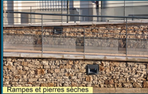
Rampes et pierres sèches
