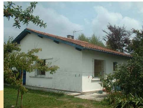
Avant rénovation et extension.
