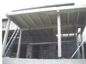
Les Structures en bois le 1er étage en cours
