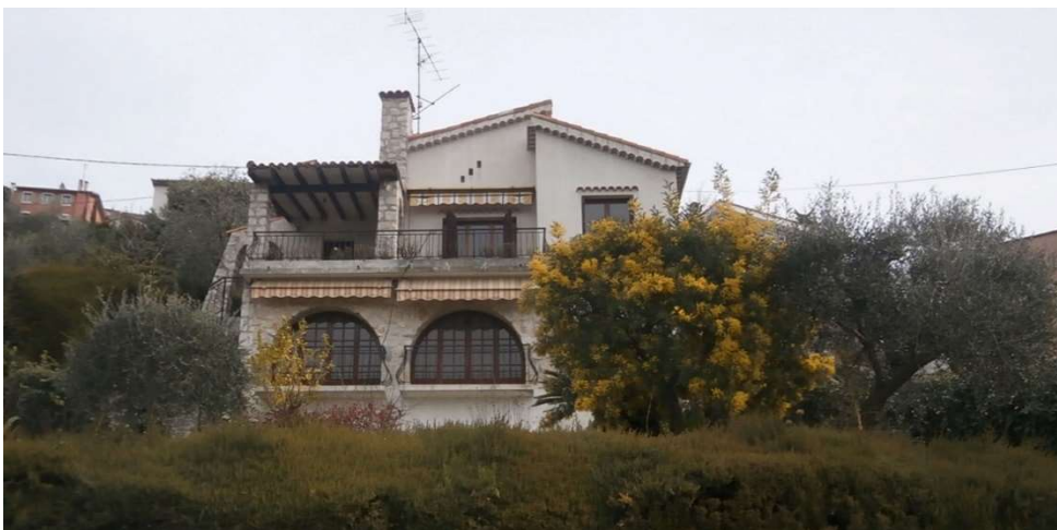
Photo avant intervention
