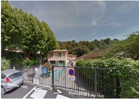
Vue du bâtiment existant
